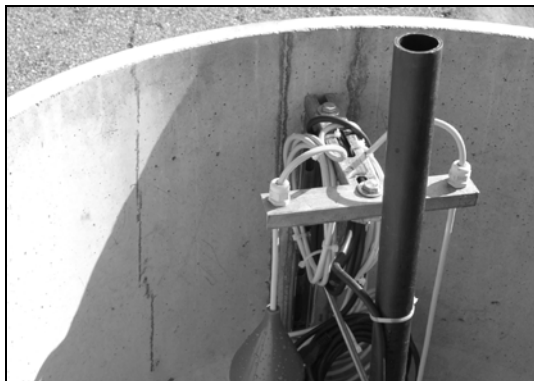
Bild 14: Befestigte Pumpenschachtausrüstung
