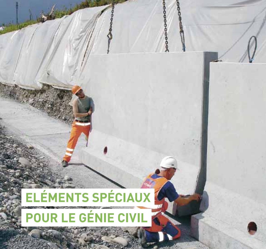
Mur de soutènement à la sortie d'autoroute Thoune-sud
