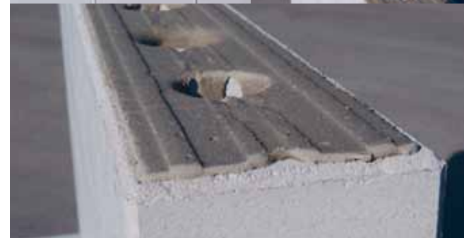
Application rapide et régulière du mortier en bain mince à l'aide du chariot mortier.
